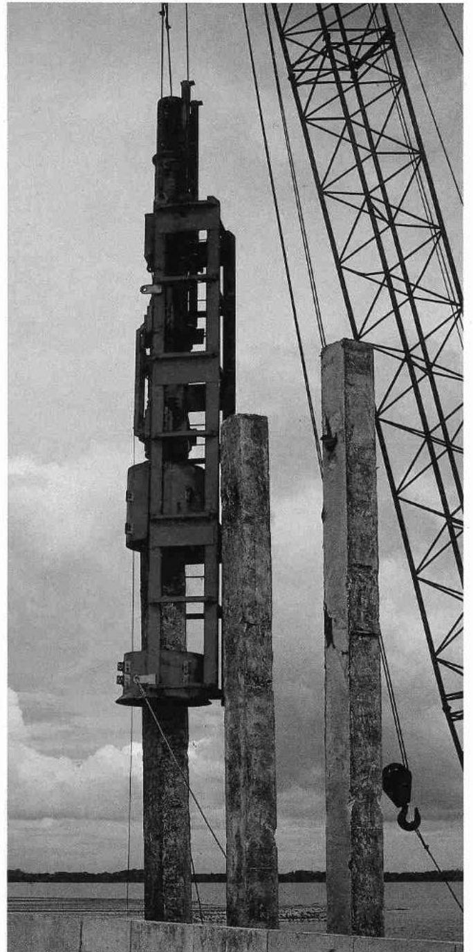
Foto derecha, balancín para despegue y transporte de pilotes; foto izquierda, hincado de pilote con martillo D-36.
