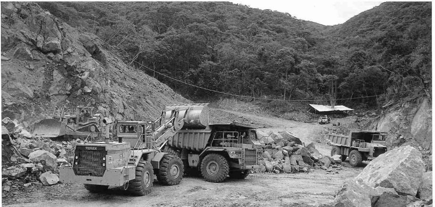
Banco de explotación de roca para la cortina.
