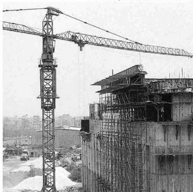
Vista lateral de la fachada norte del módulo 3; cimbra a triple altura para la cornisa de remate.
