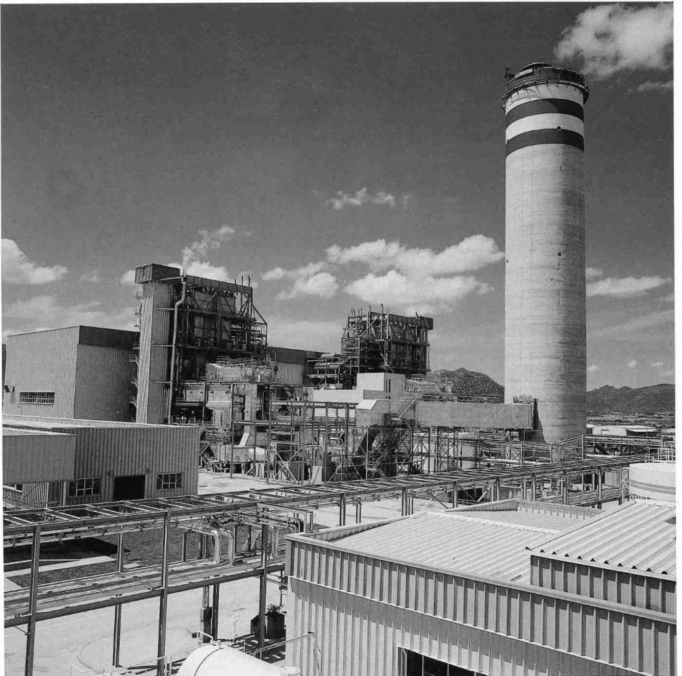
Vista exterior e interior de la termoeléctrica Lerdo.
